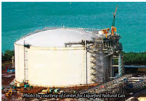
1.4: Cryogenic tank storing LNG at -162^{\circ}\text{C} .
